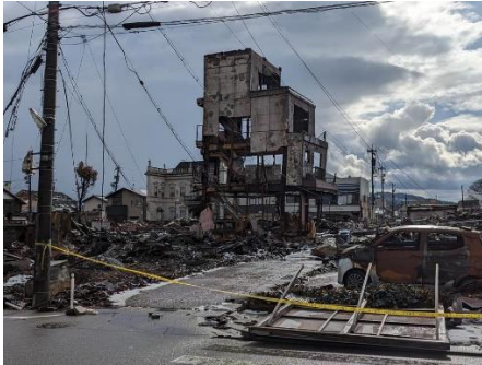
【視察の道中の被災の様子】火災跡
